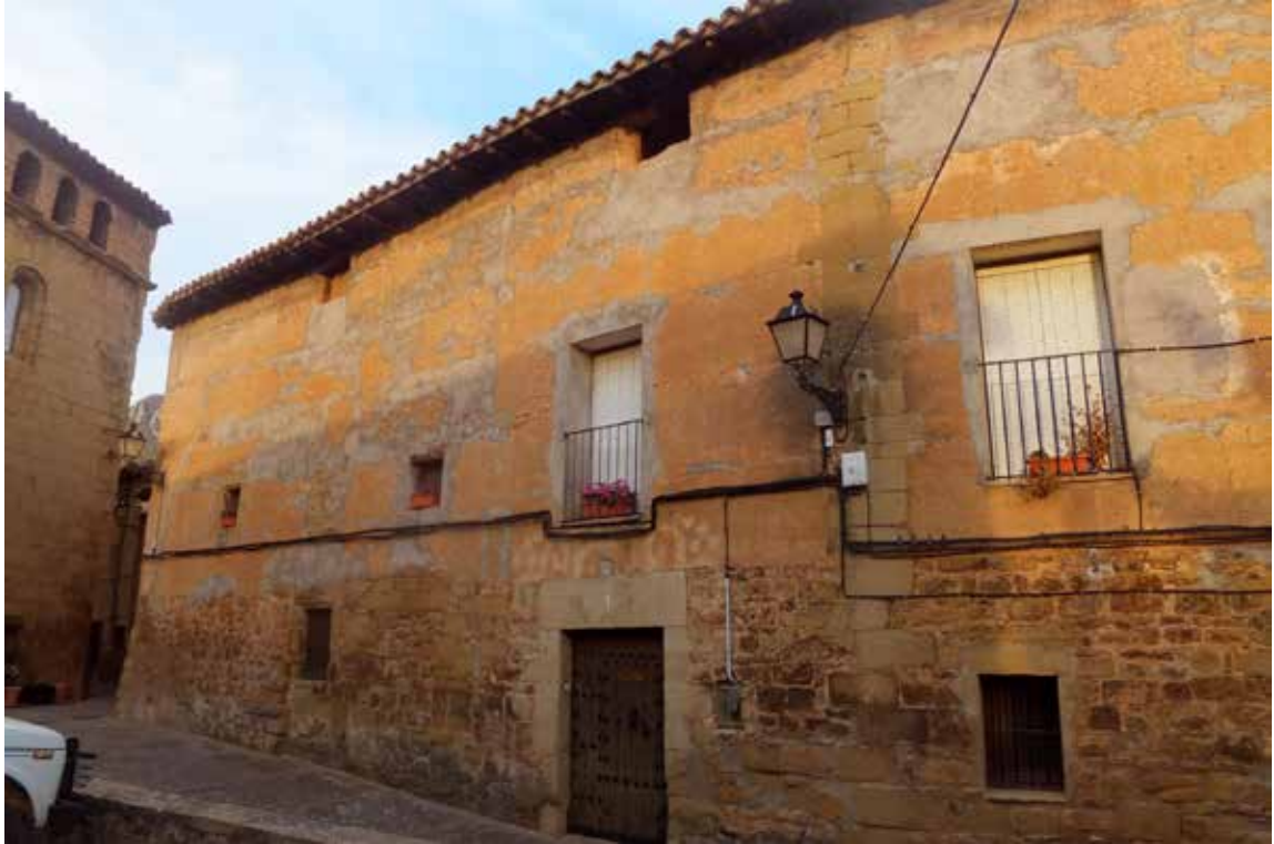
Figura 1. Imagen de la una fachada de tapia calicostrada tradicional en Agüero (Huesca). (Fuente: la autora).
