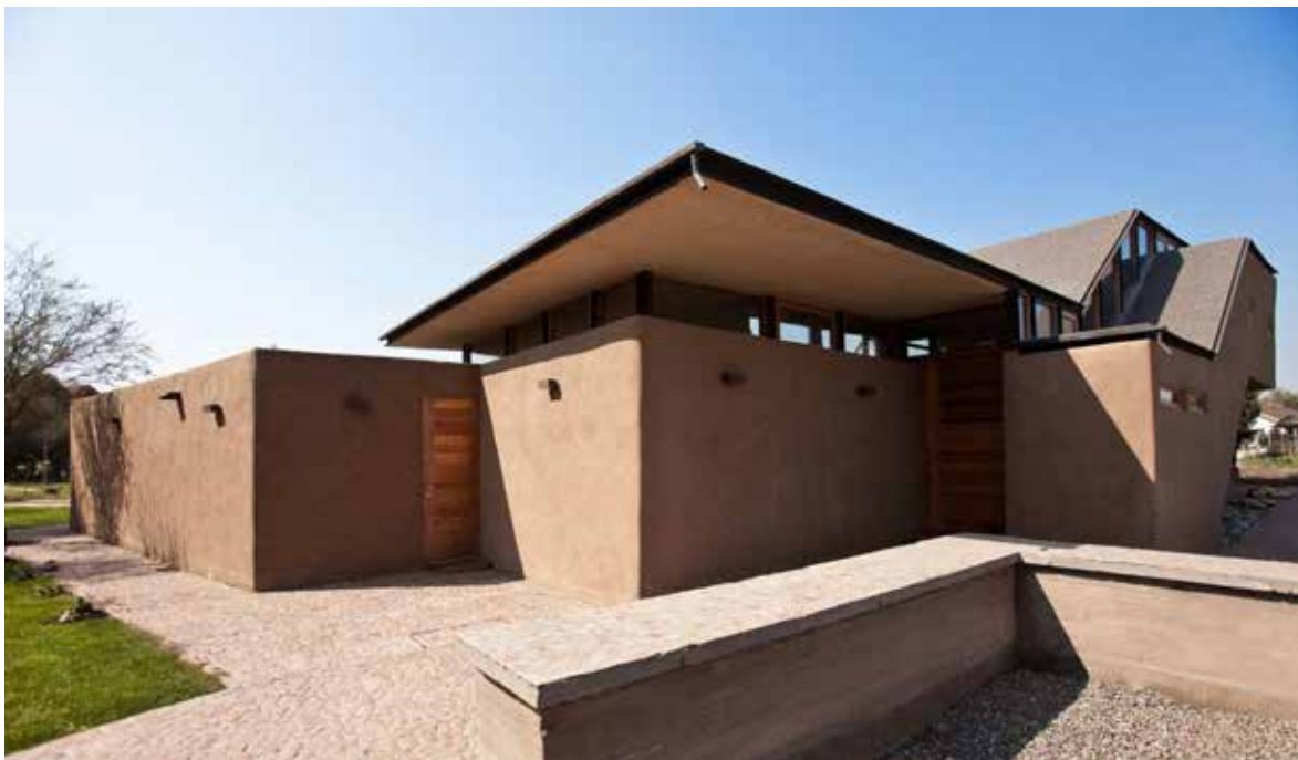
Figura 14. Vivienda de estructura de acero y relleno de tierra, obra de Surtierra Arquitectura. Créditos: Surtierra Arquitectura. http://www.surtierraarquitectura.cl/
