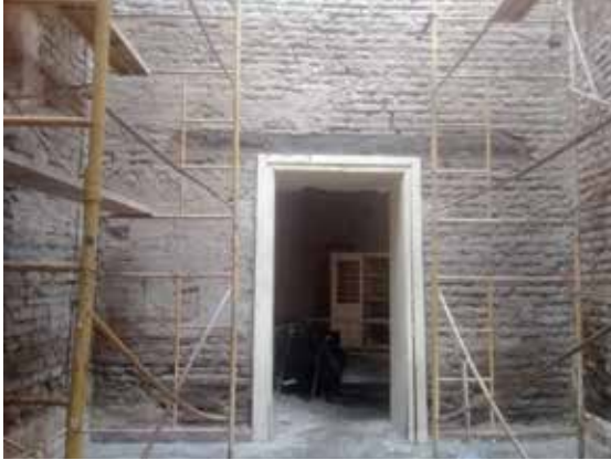
Figura 5. El adobe representa la mayor parte de la materialidad en obra. Fuente: Archivo de COEMYC S.A.
