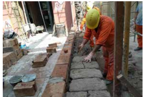
Figura 8. Reconstrucción del muro de adobe y su revestimiento de ladrillo cocido. Fuente: Archivo de COEMYC S.A.
