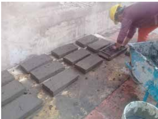
Figura 9. Elaboración de nuevos adobes en obra. Fuente: Archivo COEMYC S.A.
