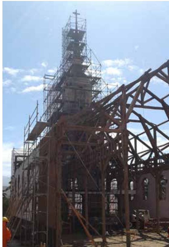
Figura 13-14. Proceso de desarme de la Iglesia Santa Rosa de Lima, 2016. Fuente: Propia.
