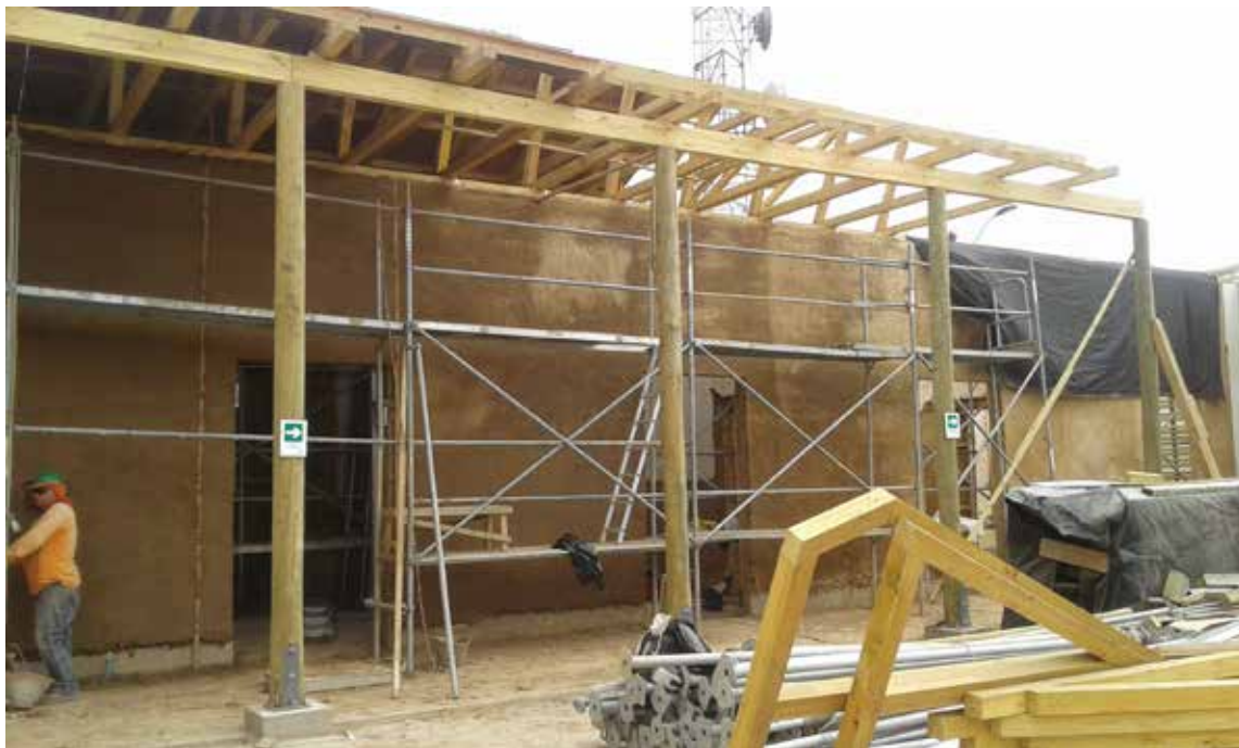
Figura10. Restitución de revoques Edificio Los Portales, 2017. Fuente: Propia.
