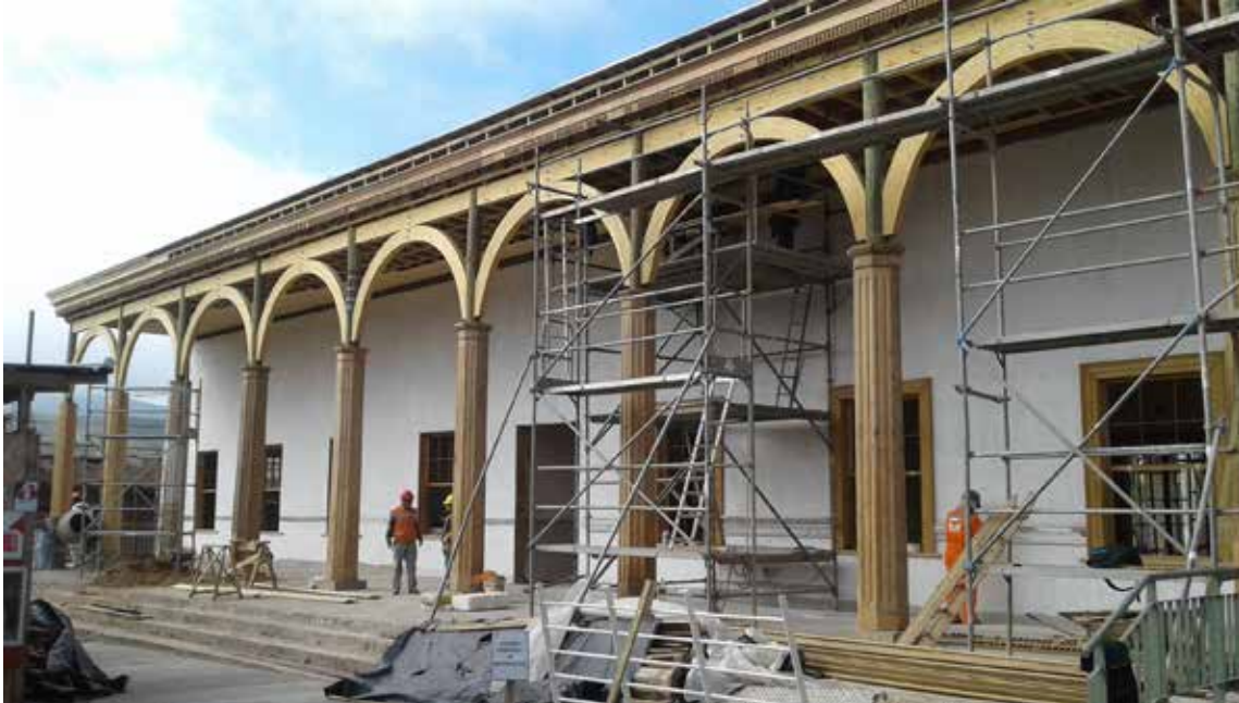
Figura 11. Restauración de la fachada principal del Edificio Los Portales, 2017. Fuente: Propia.
