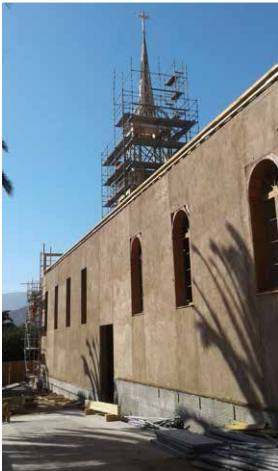
Figura 17-18. Proceso de restitución de revoques y acabados de cal, 2017. Fuente: Propia.
