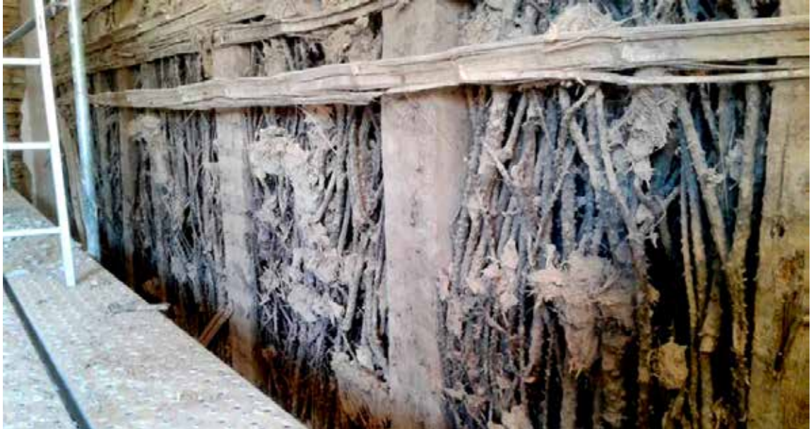
Figura 2. Relleno de la Quincha en la Iglesia Santa Rosa de Lima, 2016. Fuente: Propia.
