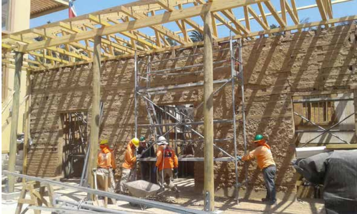
Figura 9. Restitución de armadura de techumbre Edificio Los Portales, 2017. Fuente: Propia.
