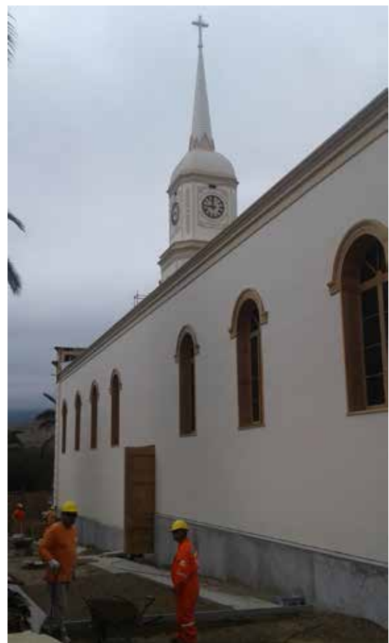
Figura 17-18. Proceso de restitución de revoques y acabados de cal, 2017. Fuente: Propia.
