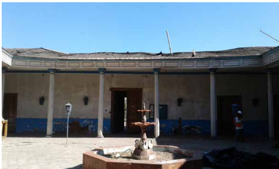
Figura 5. Patio interior del Edificio Los Portales, previo a su intervención, 2016. Fuente: Propia.
