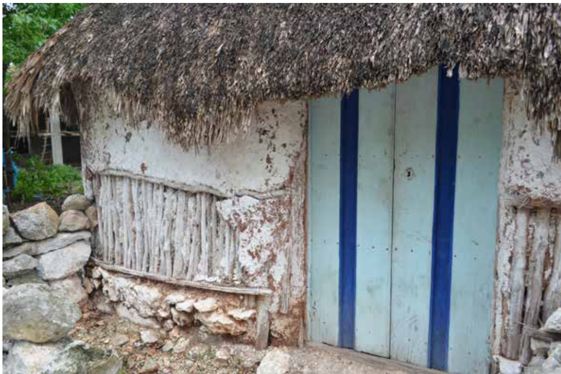
Figura 6. Vivienda con muros de bajareque con k'aankab ; por el deterioro del muro se puede apreciar los materiales y el sistema constructivo. Nunkiní, Campeche. Fuente: Tomada por el autor, 2015.
