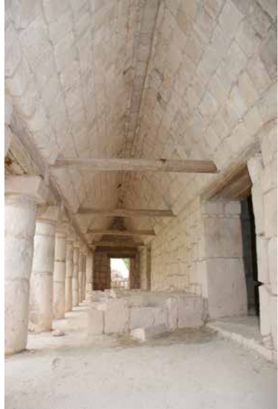
Figura 1. Bóveda maya con maderos en rollizos que semeja el baalo de la casa vernácula maya, en el Templo de las Columnas en Uxmal, México. Fuente: Tomada por el autor, 2009.
