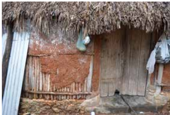
Figura 3. Detalle del muro de bajareque en el que se aprecia la estructura de madera (kololche) amarrada con bejuco y recubierta con el barro (pak'lu'um). Nunkiní, Campeche. Fuente: Tomada por el autor, 2015.
