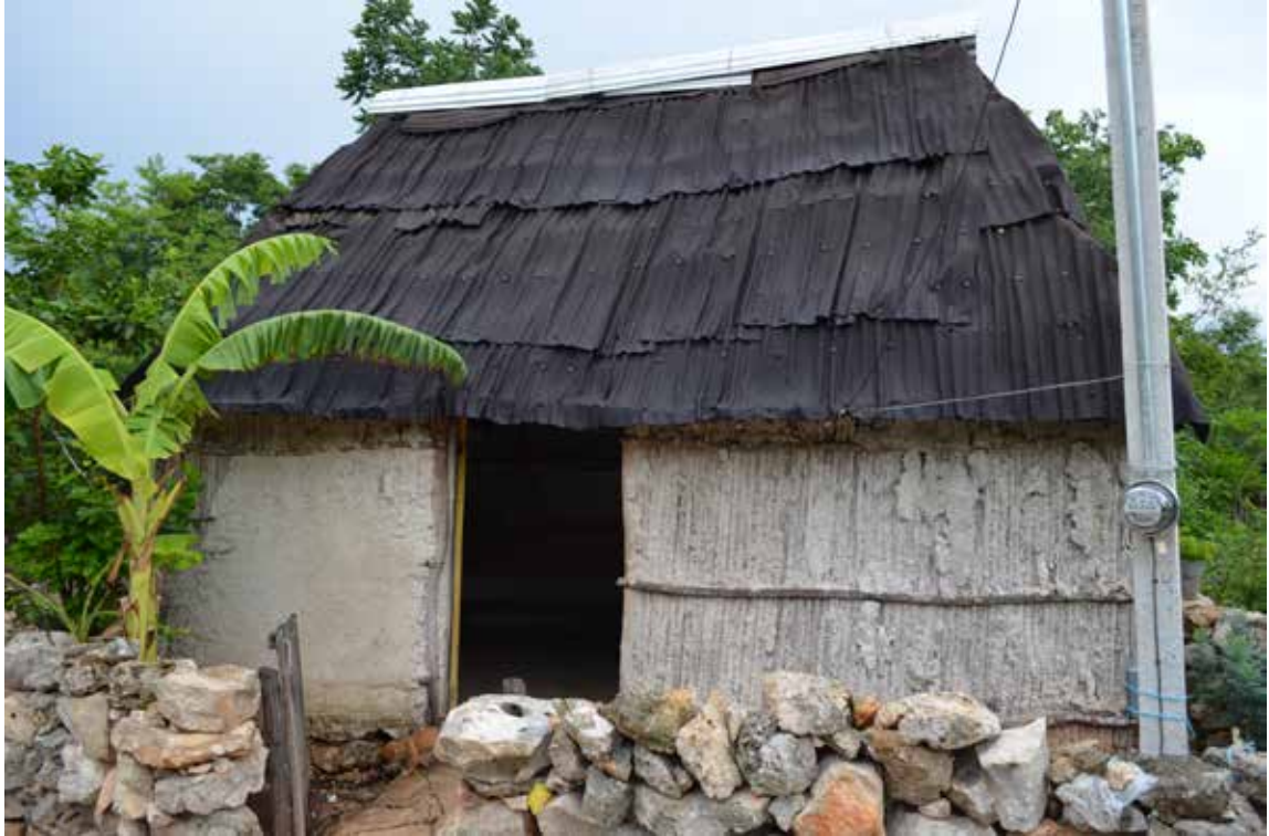
Figura 5. Vivienda con muros de bajareque con sajkab, la única identificada de un total de 502 casas registradas en Nunkiní, Campeche. Fuente Tomada por el autor, 2015.
