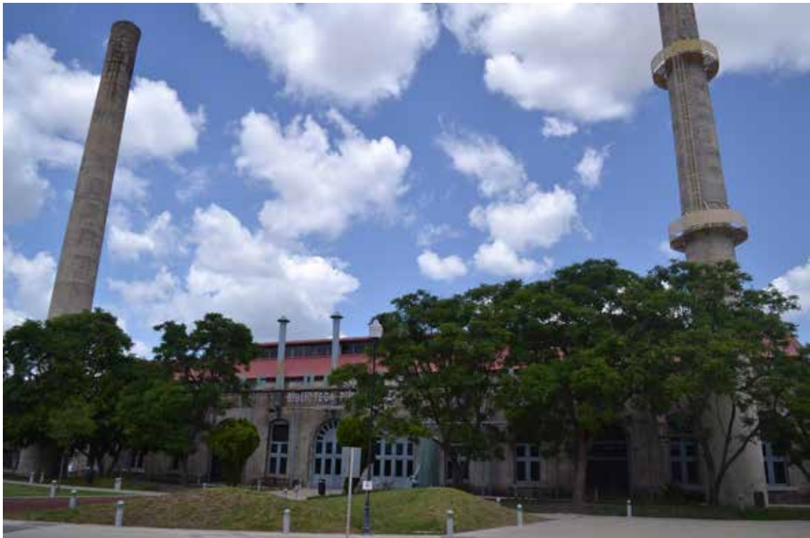
Figura 5. Restauración de la Casa de Fuerza, hoy Biblioteca Pública Central. Fotografía captada el 11-09-2016, por Ana Paulina Sotomayor Mora.
