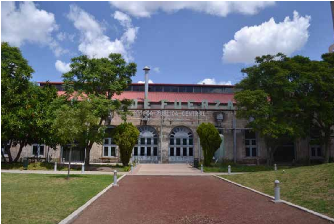
Figura 13. Biblioteca Pública Central. Edificio importante, debido a su arquitectura y a que en éste se encontraba el silbato que daba aviso del inicio y fin de la jornada laboral. Aún conserva el letrero “Casa de Fuerza”. Fotografía captada el 11-09-2016, autor Ana Paulina Sotomayor Mora.
