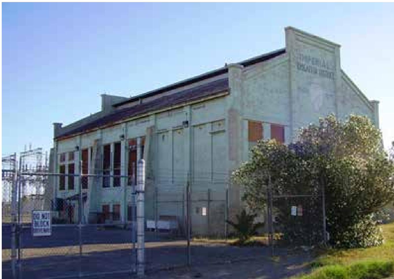
Figura 3. Edificio de la casa de máquinas del Imperial Irrigation District del valle Imperial, IID, construido en 1915. El Centro, California. ca. 2016. Fuente. Col. C. Robles.
