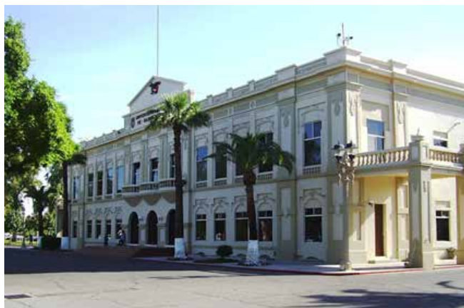
Figura 12. Palacio de Gobierno del Distrito Norte de Baja California, actualmente Rectoría de la Universidad Autónoma de Baja California Mexicali, B.C., ca. 2016. Fuente. Col. C. Robles.
