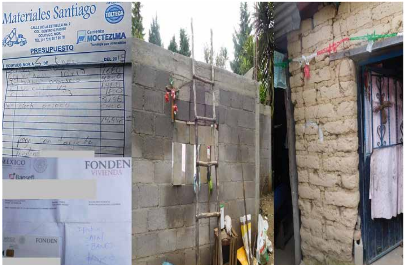
Figura 5. Adquisición de material de construcción con recursos del FONDEN para la reconstrucción de vivienda vernácula. Fabiola B. Herrera Rivas. 10 de febrero de 2018.
