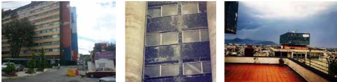
Figura 9. Los exteriores de edificios dan cuenta del paso del tiempo y falta de mantenimiento. FUENTE. [Fotografías de Michelle Reza Flores]
