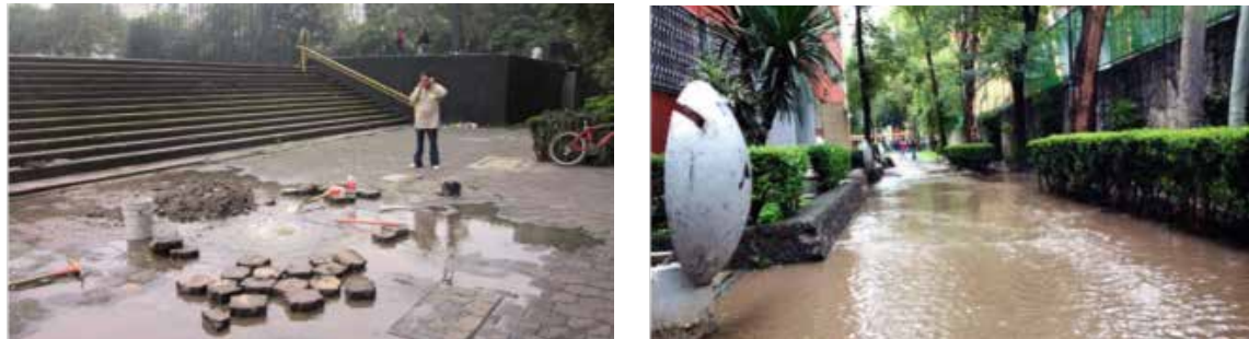
Figura 8. Los problemas de fugas son comunes, debido al rompimiento de la red de baja presión, lo que ocasiona que se queden sin agua los residentes, principalmente los pisos del 1 al 7, mientras se realizan las acciones necesarias. FUENTE. [Fotografías de Michelle Reza Flores]
