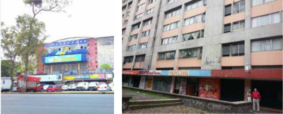
Figura 12. Deterioro de imagen urbana, falta de mantenimiento y vandalismo. FUENTE. [Fotografías de Michelle Reza Flores]
