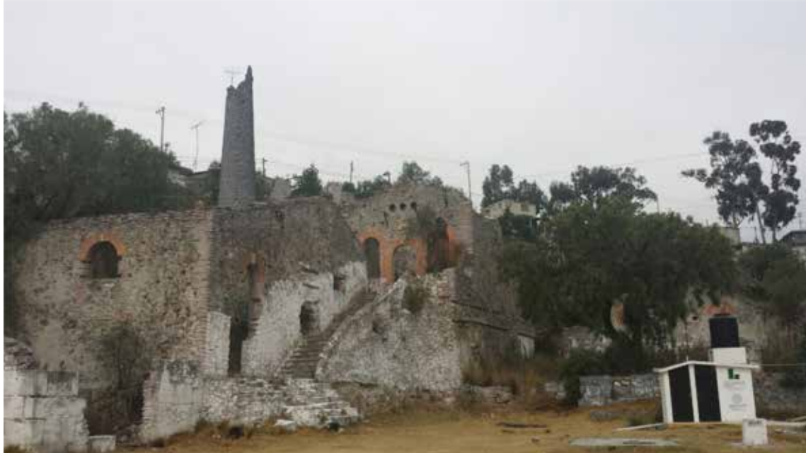
Figura 7. Vestigios de las casas de máquinas de la Mina de Camelia. ELA 2016.
