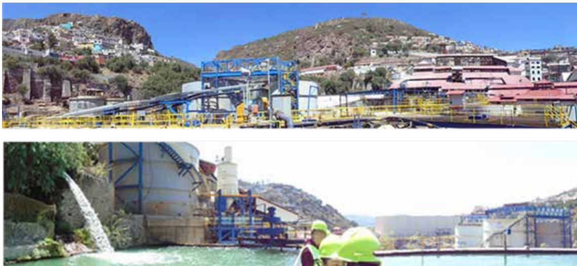
Figura 4. Instalaciones de la Mina de Loreto, modernizadas en 2010 (3 marzo 2018 MESR).
