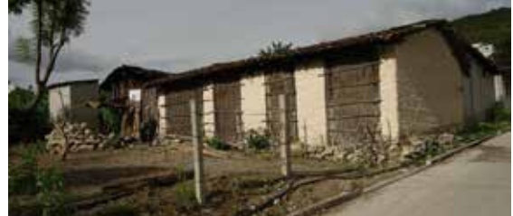
Figura 7. Forma de estructuración de elementos divisorios con recursos vegetales. Fotografía: San Miguel Tlacotepec, Oaxaca, México-septiembre 2012. Autor: R. A. León.
