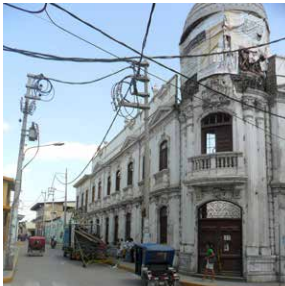
Figura 3. Vista exterior de la demolición interior. Foto: F. Carbajal B.
