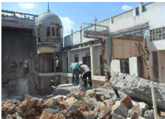
Figura 1. Demolición usando rotomartillo. Foto: F. Carbajal B.
