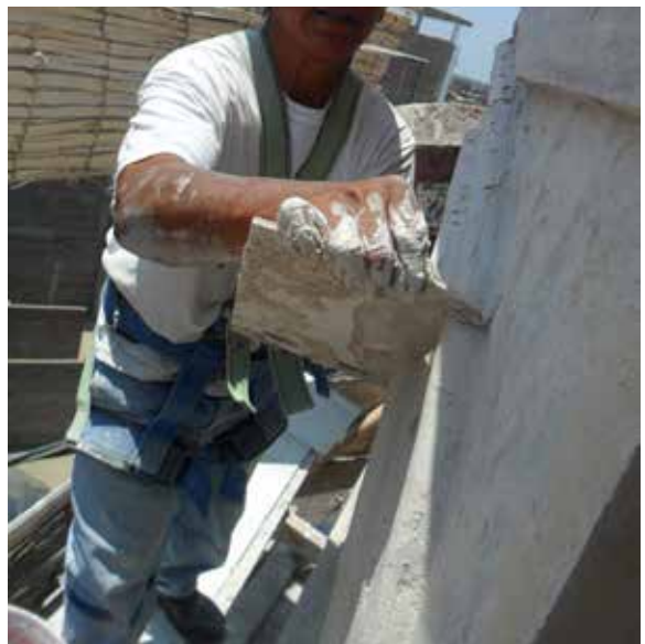
Figura 9. Restauración de moldura en la cúpula; puede verse el uso de una tarraja metálica. Foto: F. Carbajal B.
