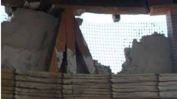
Figura 13. Este sector pertenece al muro de la cúpula. Por su mal estado tuvo que cambiarse todo. Puede verse el bastidor de madera con la malla plástica (PVC) rígida y el recubrimiento con caña de guayaquil chancada. En todo momento se consideró no usar torta de barro, por ser un material que contiene organismos que contribuyen a la destrucción de lo orgánico. Foto: F. Carbajal B.
