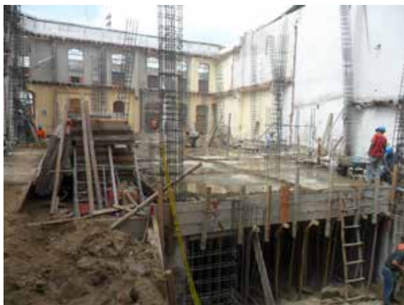
Figura 2. Armado de la estructura del sótano. Foto: F. Carbajal B.
