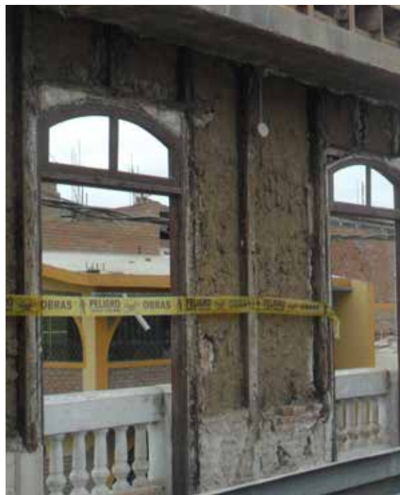
Figura 12. Puede observarse el interior del muro perimetral primigenio, al cual se le ha retirado el enlucido de yeso y parte de la torta de barro. También logra verse la nueva estructura de concreto armado, a la cual se sujeta el muro. Foto: F. Carbajal B.
