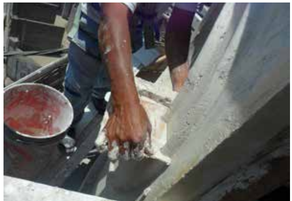
Figura 8. Restauración de una moldura vertical en la fachada. Foto: F. Carbajal B.
