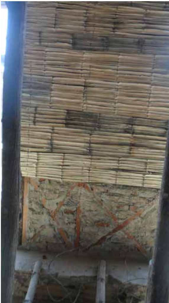
Figura 14. Módulo de bastidor de muro de quincha luego de su reparación. Puede verse el encañado, previamente curado contra insectos xilófagos, con caña de guayaquil, y en la parte inferior el muro de ladrillo que permite la estabilidad de éste. Foto: F. Carbajal B.
