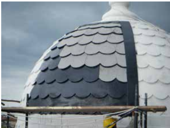
Figura 5. Colocación de teja asfáltica sobre superficie de diablo fuerte, previamente impermeabilizada con asfalto. Foto: F. Carbajal B.
