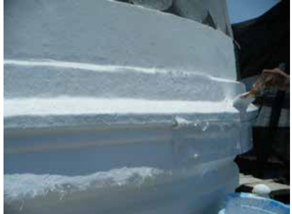
Figura 7. Colocación de banda de fibra de vidrio en la moldura de la base del domo. Foto: F. Carbajal B.
